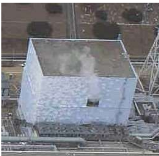
図1. 2号機のブローアウトパネルが自動的に落下して内部の水蒸気が放出されているところ
