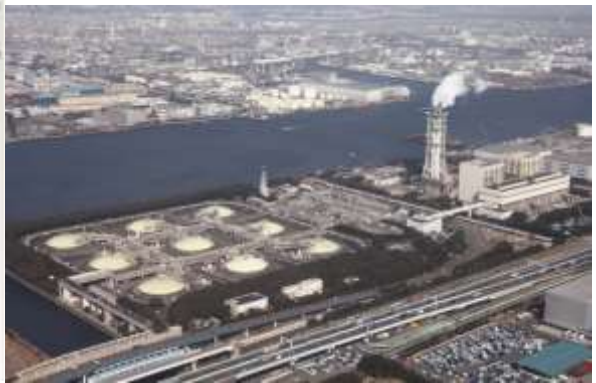
図3. 東電の東扇島火力発電所 燃料（LNG）は、ヤードのタンク内に貯蔵されており、その瞬間の燃焼分だけボイラ内に導入される
