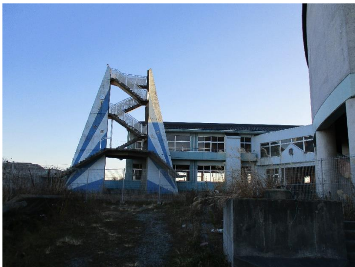
図3. 請戸小学校の海側（時計塔が3時38分を指して止まっている）
